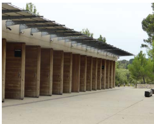
Site après restauration : passerelle piétonne et maison de site
