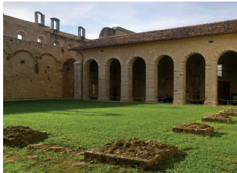
Cloître mauriste, détruit au XIX e siècle. Les pierres taillées ont été remployées dans les maisons du village. © CCPOA - 2021
