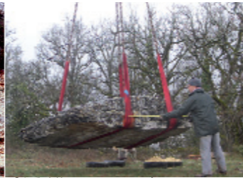
Restauration du dolmen
