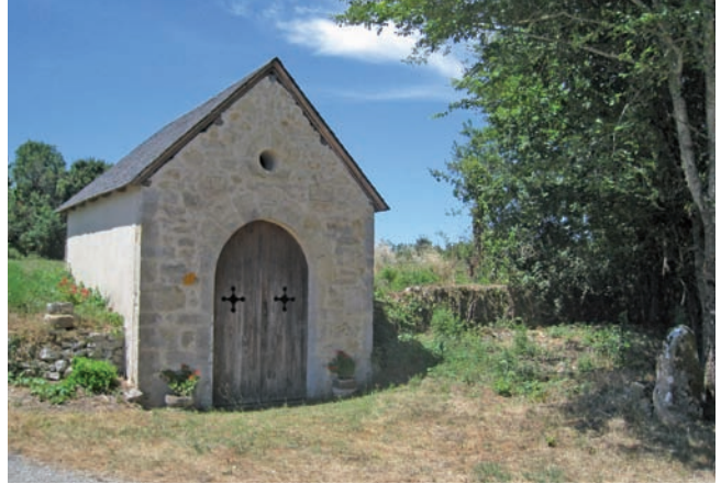
Réouverture d'une ancienne chapelle tombée en désuétude au cœur du bourg, à proximité d'un point d'eau et de toilettes publiques/ GR®65 à Cras (Lot)
