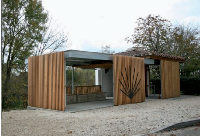
Restructuration d'un ancien bâti (arrêt de bus et toilettes publiques) pour répondre à l'accueil de randonneurs mais aussi à des usages locaux - GR®65 à Bach (Lot) - Architecte David Hebert
