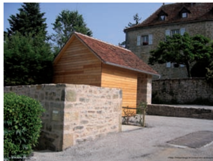
Ancien appentis reconverti en sanitaire public à Thégra / PhBA Architecte
