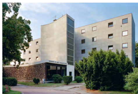
La Fondation suisse, pavillon Le Corbusier, Paris.
