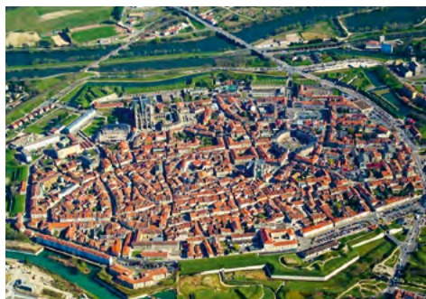
Vue aérienne de l'enceinte bastionnée de Toul.
