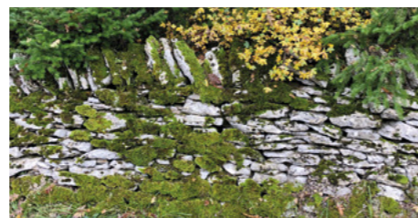
Mur de pierre sèche
