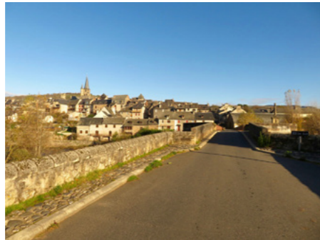
Le pont de Saint-Côme-d'Olt
