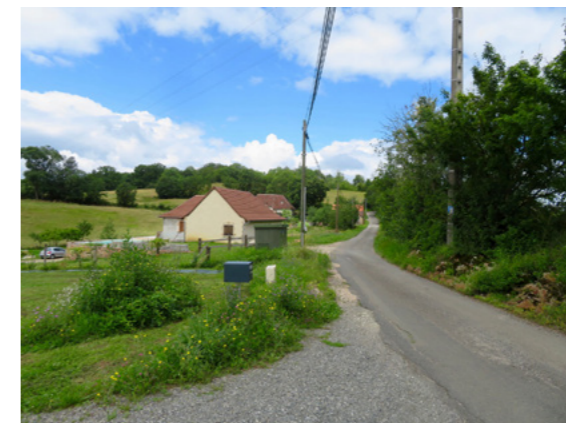
Dynamiques d'urbanisation diffuse aux abords du Chemin sur la commune de Bédier
