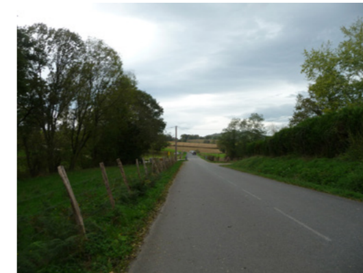
Le long de la D242, section non sécurisée avant Larribar
