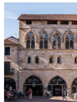
CHÉMINES PAÏSANS Diagnostic- Tronçon 3
