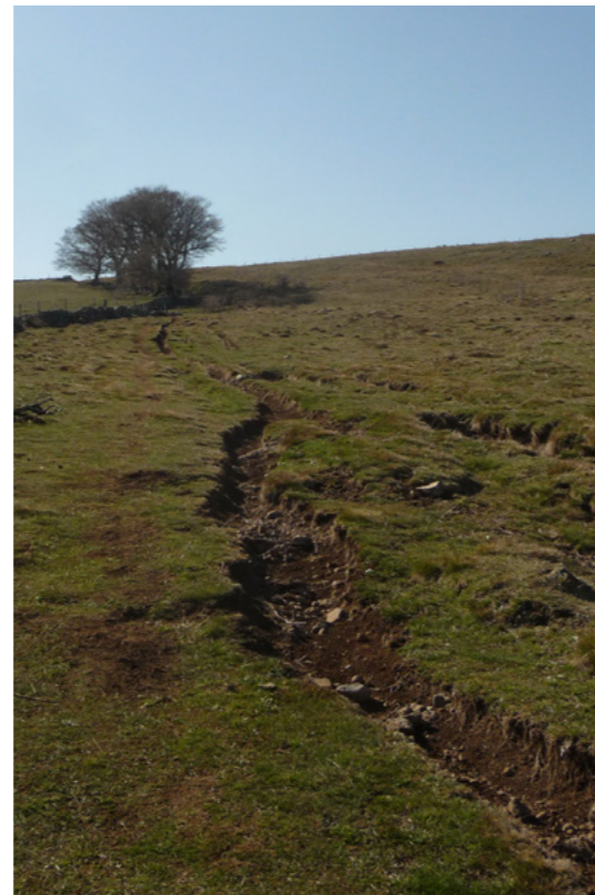
Érosion du chemin sur les estives
