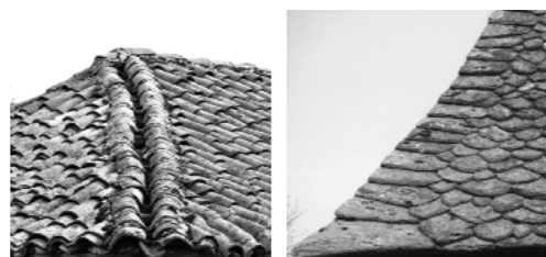
Grange étable, couvertures en lauzes ou en tuiles canal.
