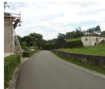
Traversée du centre-bourg de Saint-Félix
