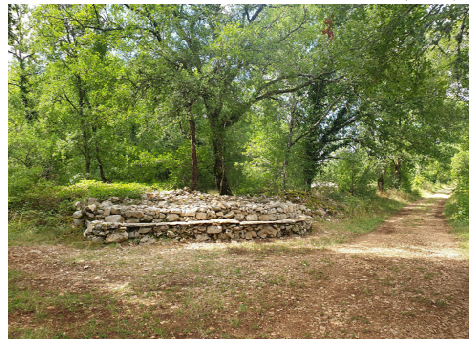
Des espaces de pause qui s'intègrent au maillage de muret le long du chemin.
