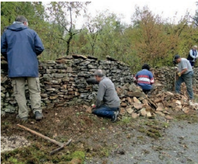
Remise en état des murets lors de l'événement « 1 000 mains à la pâte pour le GR 65 »
